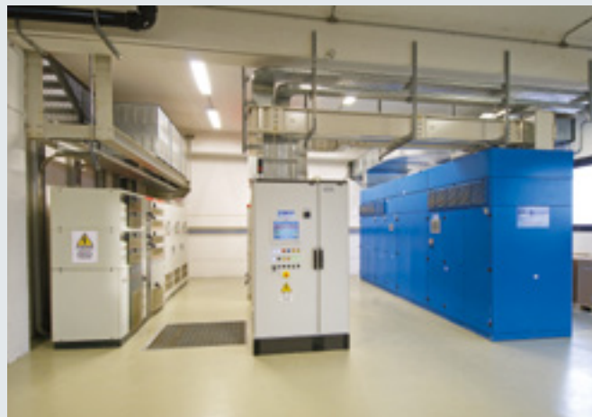
A sinistra: un particolare della centrale tecnologica con inverter fotovoltaici, quadro di controllo PLC/software e UPS a massa rotante 1,5 MW. Sotto: cogeneratori CAR 234 KWelettrici e quadro di controllo con PLC.
