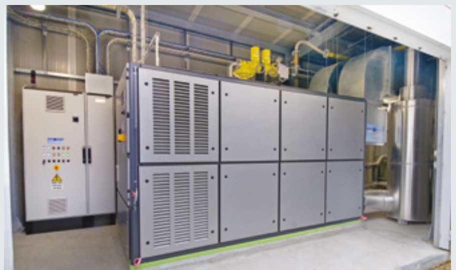
A sinistra: un particolare della centrale tecnologica con inverter fotovoltaici, quadro di controllo PLC/software e UPS a massa rotante 1,5 MW. Sotto: cogeneratori CAR 234 KWelettrici e quadro di controllo con PLC.
