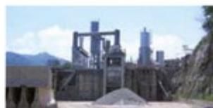
Produzione conglomerati bituminosi
