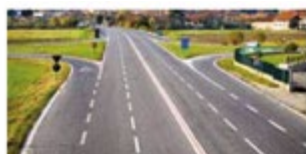
Opere stradali e opere edili
