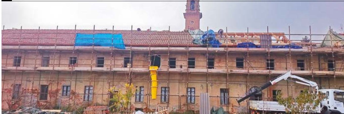
Lavori in corso. Oltre al tetto, occorre rimettere completamente mano ai muri portanti dell'ala e ai locali interni dove hanno bisogno di intervento pavimenti, muri, serramenti e impianti.
